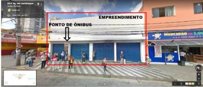
1) Ponto de ônibus em frente à entrada de pedestres do Empreendimento, na Rua Vigário João José Rodrigues
