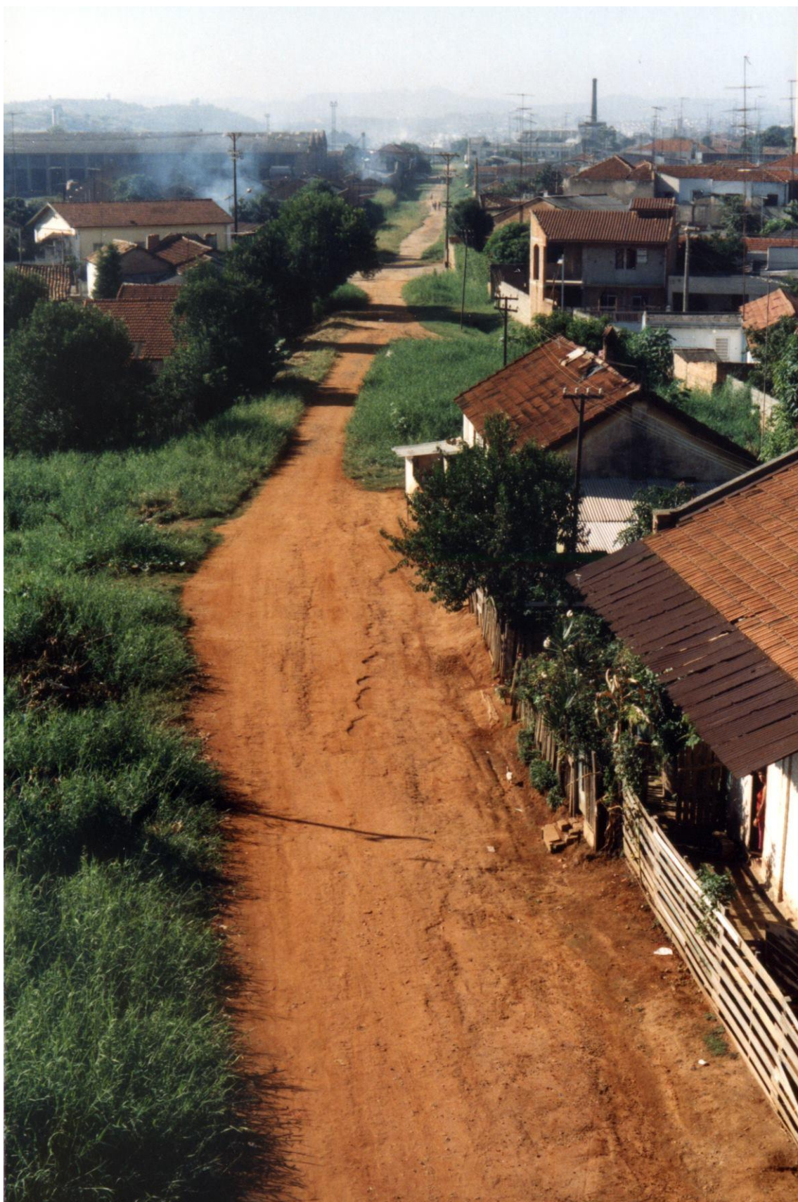
Fotografia 16 – Avenida União dos Ferroviários vista do Viaduto Joaquim Candelário de Freitas (Viaduto da Vila Rio Branco) – Vila Rio Branco
