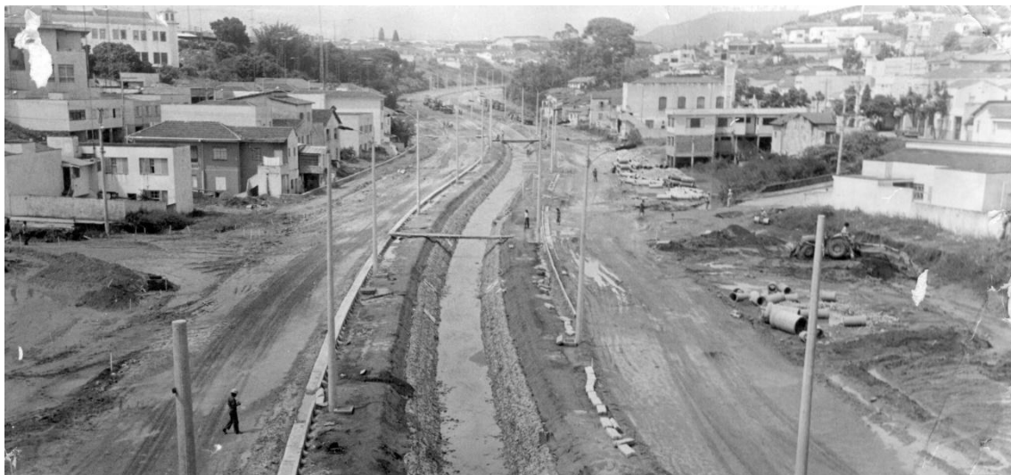
Fotografia 7 – Avenida 9 de Julho – vista do viaduto da Avenida Jundiaí - Anhangabaú
